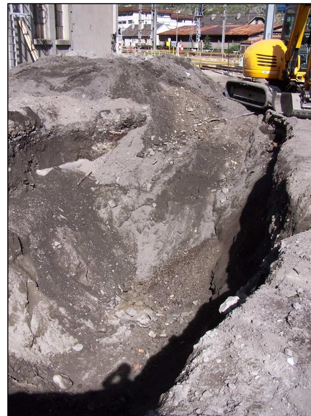
Vue du flanc nord-ouest de la fouille
