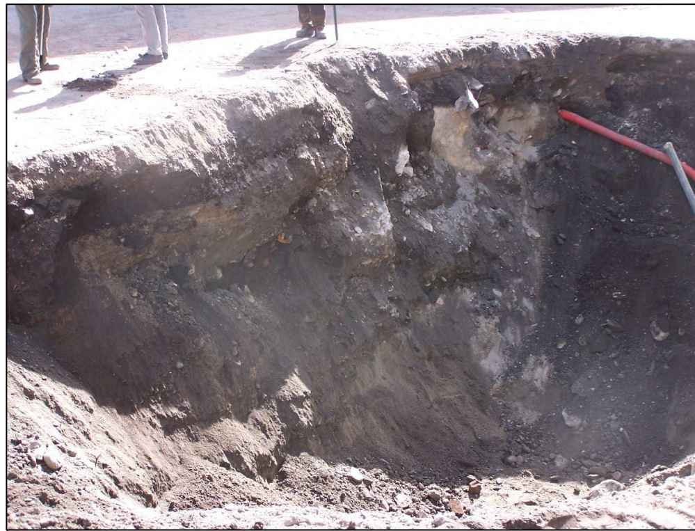
Vue du flanc nord-est de la fouille
